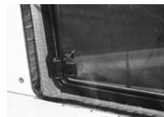
Aufstellfenster: Bringen Sie das selbstklebende Flauschband erst unten an und befestigen das untere, vordere Druckknopfunterteil, vgl. Pfeil in Abb. ▶
